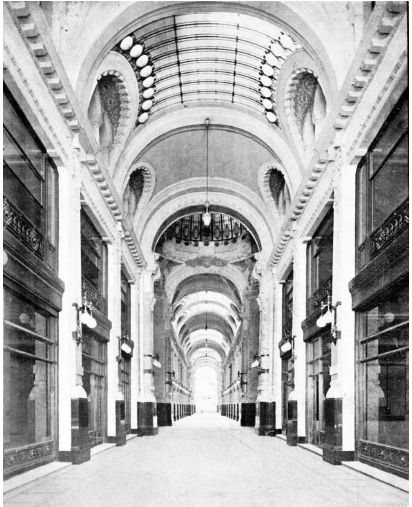
Galería Güemes. Revista Técnica y Arquitectura , 1916.
